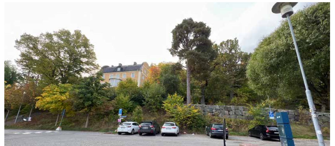
Fabrikörsvillan frontar ankomsten till det historiska bryggläget, och är tydligt inspirerad av Sjtöullens byggnader uppförda på 1700-talet.
